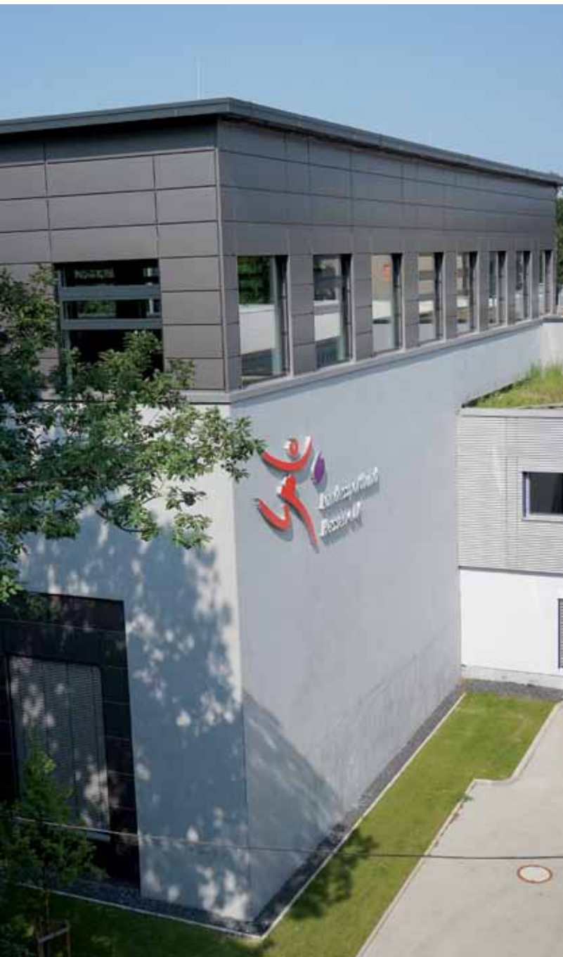
Blick auf die neue, moderne Sporthalle des Landessportbundes Hessen in Frankfurt.
