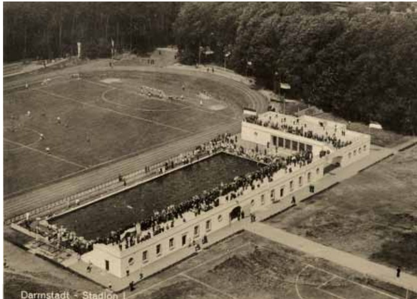
Beim Darmstädter Hochschulbad ist das 50m-Becken in die Stadionanlage mit Fußballplatz und Laufbahn integriert. Foto: Stadearchiv Darmstadt ST 53
