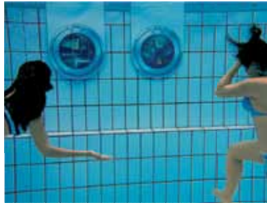
Durch Bullaugen unter Wasser waren die technischen Anlagen unter Wasser zu besichtigen. Foto: hmf, K. Streicher
