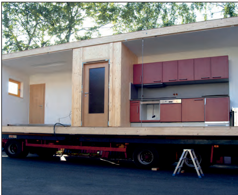
Zum Transport verladen – komplett eingerichtetes Modul eines Gebäudes
