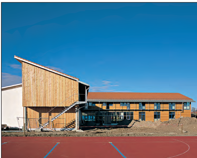
Grund- und Teilhauptschule Valley – durchgängiges Dämmstoffkonzept. Das alte Schulhaus im oberbayerischen Valley platzte aus allen Nähten. Die Übergangsregelung mit zwei Standorten, die mehrere Kilometer voneinander entfernt waren, sollte einer dauerhaften Lösung weichen. Bei dem realisierten Neubau kamen durchgängig Pavatex-Holzfaserdämmstoffe zum Einsatz. Auch für die Dämmung in den Brüstungspaneele kamen Pavatex-Holzfaserdämmstoffe zum Einsatz.
