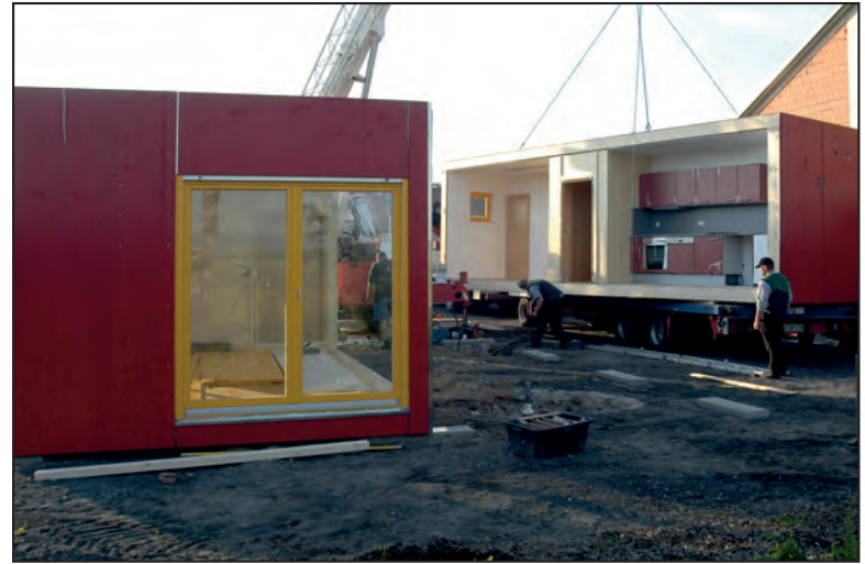
Montage der Hausmodule auf vorhandener Fläche
