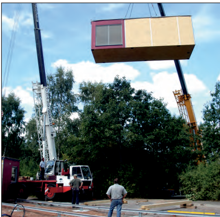
Aufstellen der Modulhäuser im Bestand
