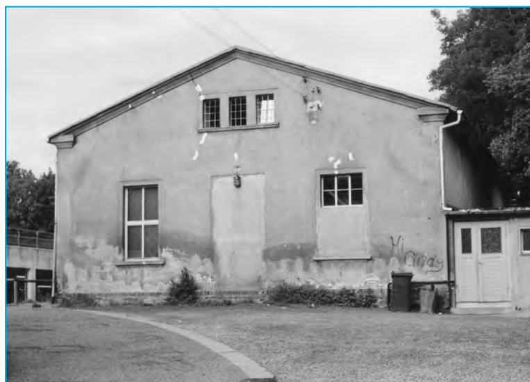
Die Planungsfrage: Was soll mit dieser Sporthalle geschehen?
